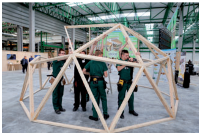
Uczniowie szkoły ponadgimnazjalnej w Czarnej Wodzie w ciągu 15 minut zmontowali szkielet budynku o powierzchni 35 m 2 .
